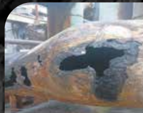
Reparo em estrutura de coluna de Amônia para tratamento de gás em coluna de destilação.
