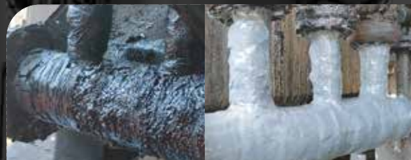
Reparo na Tubulação de Amostra Decantador - VAZAMENTOS DE LICOR DE COG
