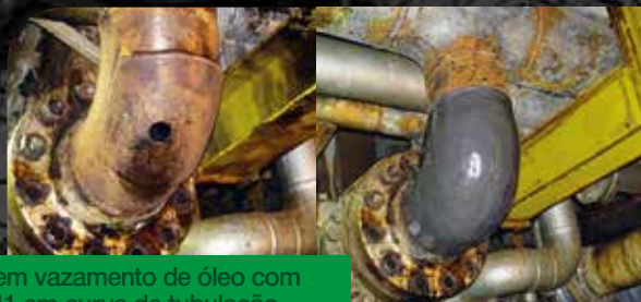
Reparo em vazamento de óleo com MAX 5611 em derivação de tubulação offshore.
