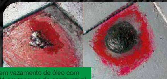
Reparo em vazamento de óleo com MAX 5611 em curva de tubulação offshore.
