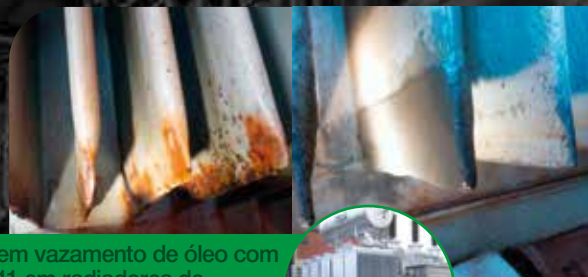
Reparo em vazamento de óleo com MAX 5611 em tanques de combustível de refinaria.
